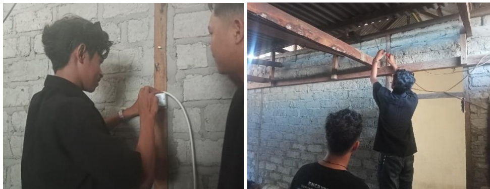
Gambar 3. Pelaksanaan Kegiatan Perbaikan Instalasi Listrik Penerangan
