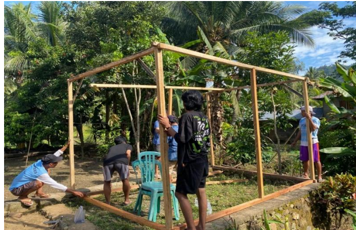
Gambar 3. Proses Pembuatan Greenhouse Untuk Pengering Kopra Putih
